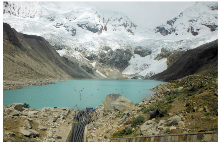
Der Gletschersee Palcacocha mit einem provisorischen Abpumpsystem im Vordergrund, das nicht ausreichend ist, um eine gefährliche Flutwelle zu vermeiden.
