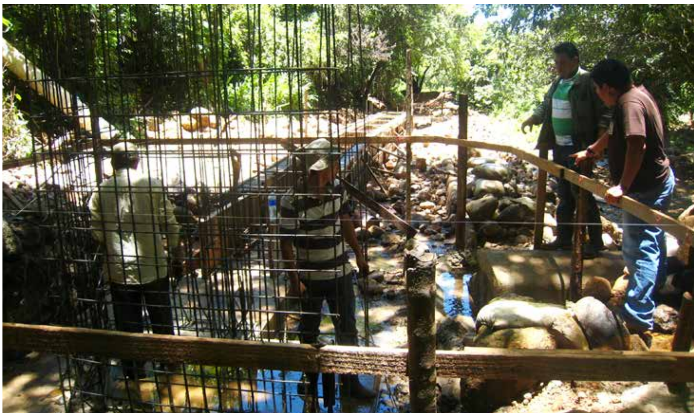
Préparation des canalisations d'eau dans le Las Mercedes, El Sauce au Nicaragua
