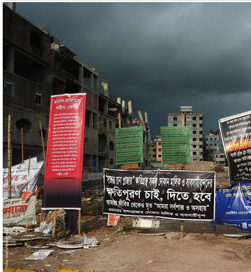
Der Einsturz des Rana Plaza Hochhauses in Bangladesch kostete über 1.100 Menschen das Leben.
