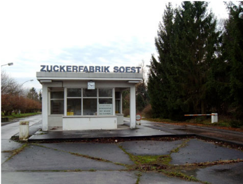
Abb. 2: Die geschlossene Zuckerfabrik in Soest.
