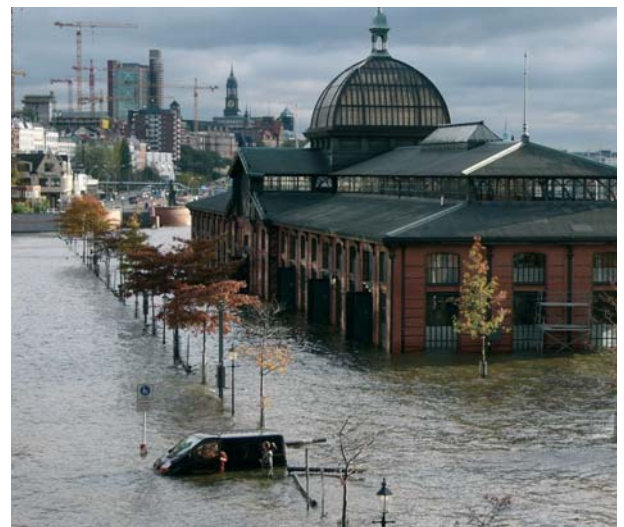
Hochwasser auf der Grossen Elbstraße in Hamburg am 01.11.2006. Der Fischmarkt steht unter Wasser. Foto: Max Seiler / Greenpeace
