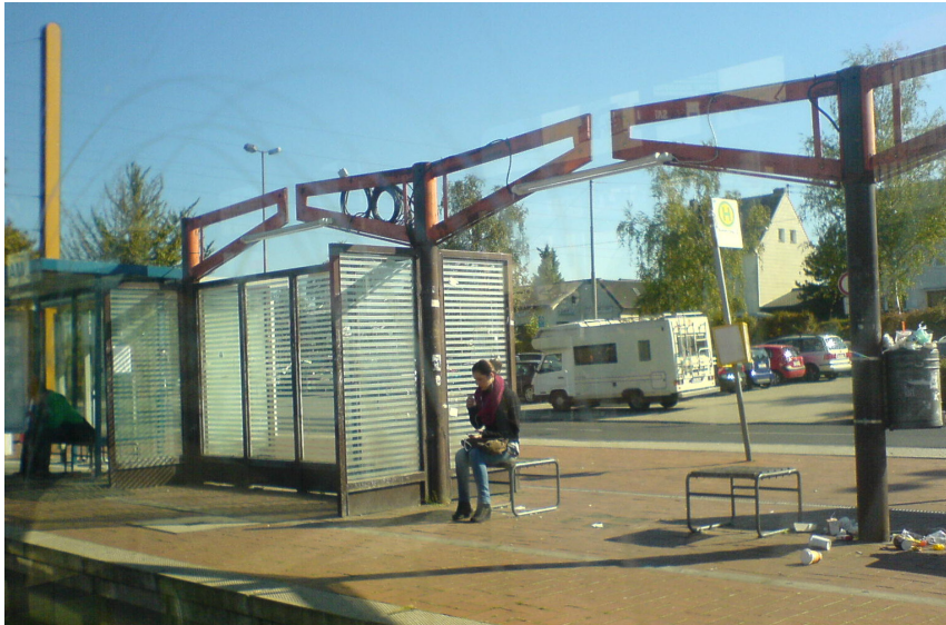
Fehlende Überdachung einer Stadtbahnhaltestelle: Zerfall unter Nutzung.
