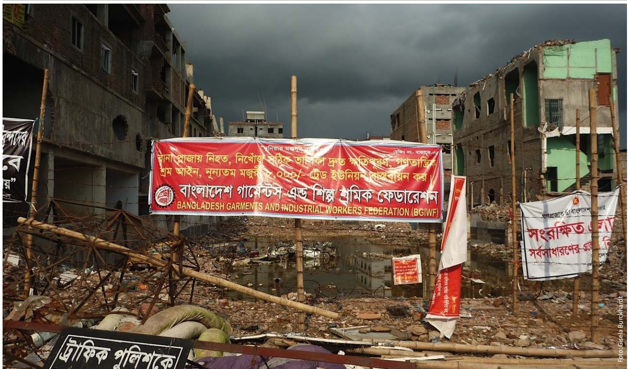
Eine Fabrik des Rana Plaza Komplexes war kurz vor dem Einsturz auditiert worden, aber dadurch konnte die Katastrophe nicht verhindert werden.
